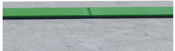
Figure 4 : Traitement de raccordement entre deux bandes
