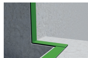
Figure 12 : Positionner la bande parallèle à la largeur de l'appui
